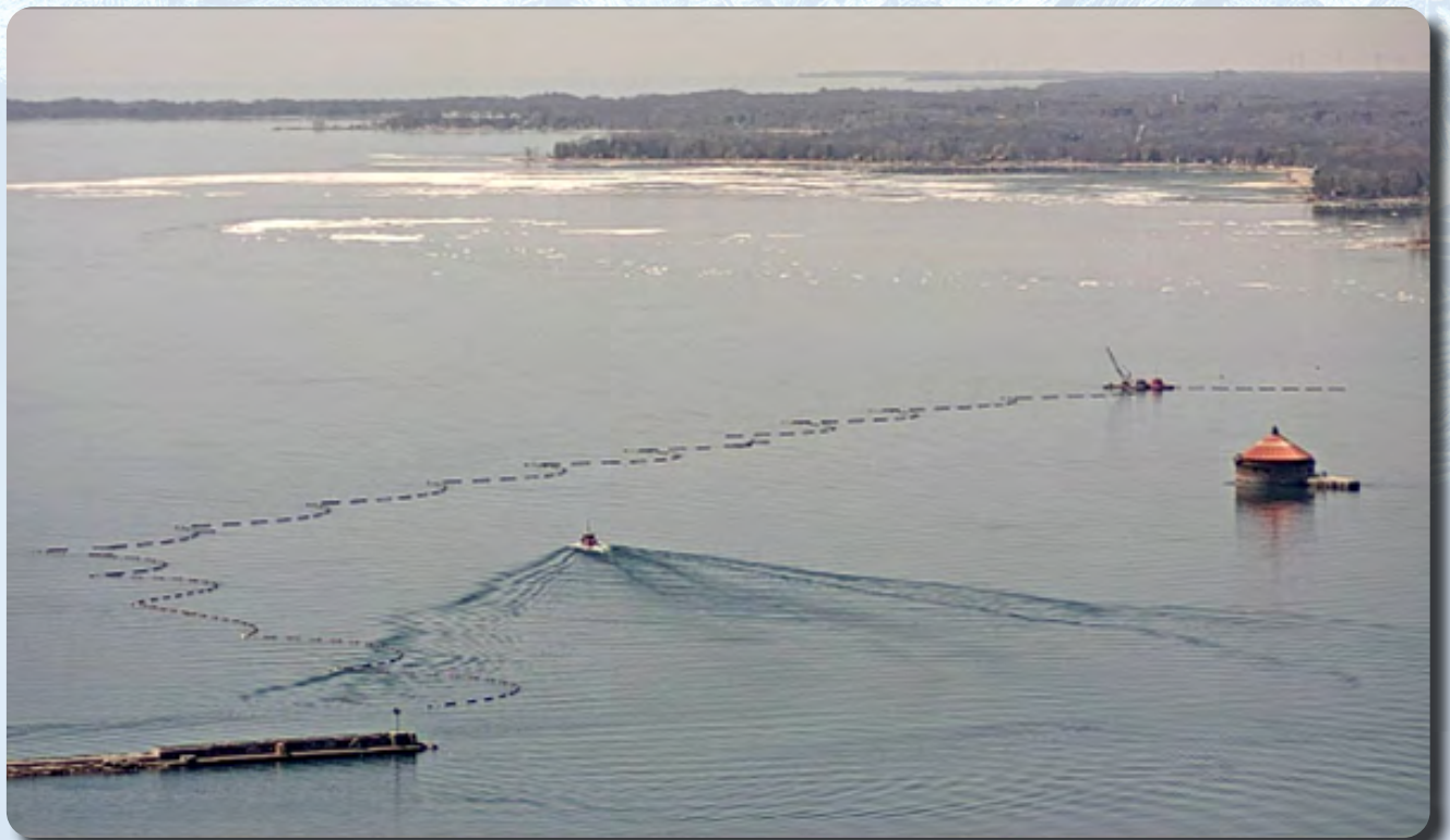
La New York Power Authority installe des sections de l'estacade à glace dans le lac Érié en décembre 2021. Photo : New York Power Authority.
