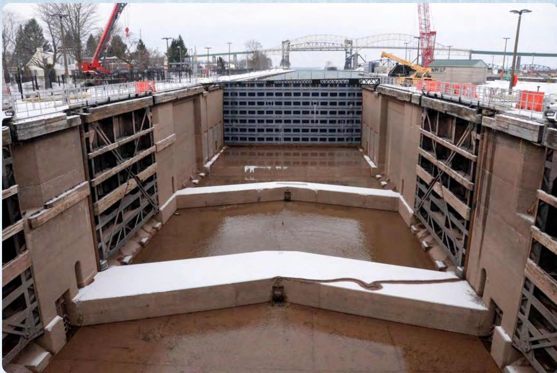
L'écluse MacArthur a été asséchée en prévision de l'entretien hivernal. Photo : US Army Corps of Engineers, district de Detroit.
